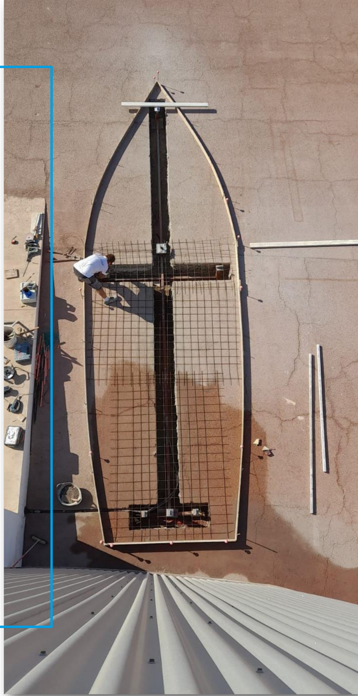
Colocación de mallazo interior.
