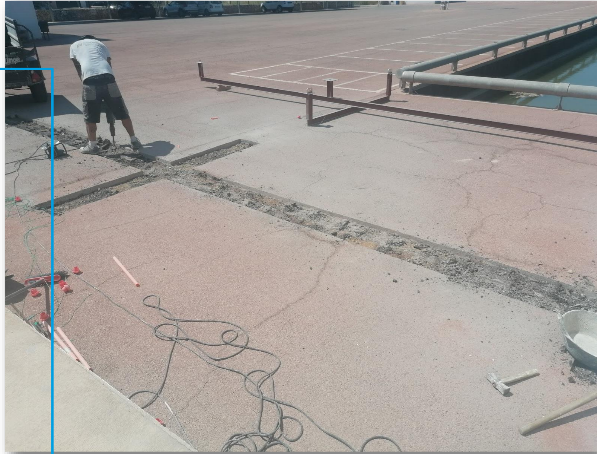
Picado de zanja para estructura metálica de refuerzo interior.
