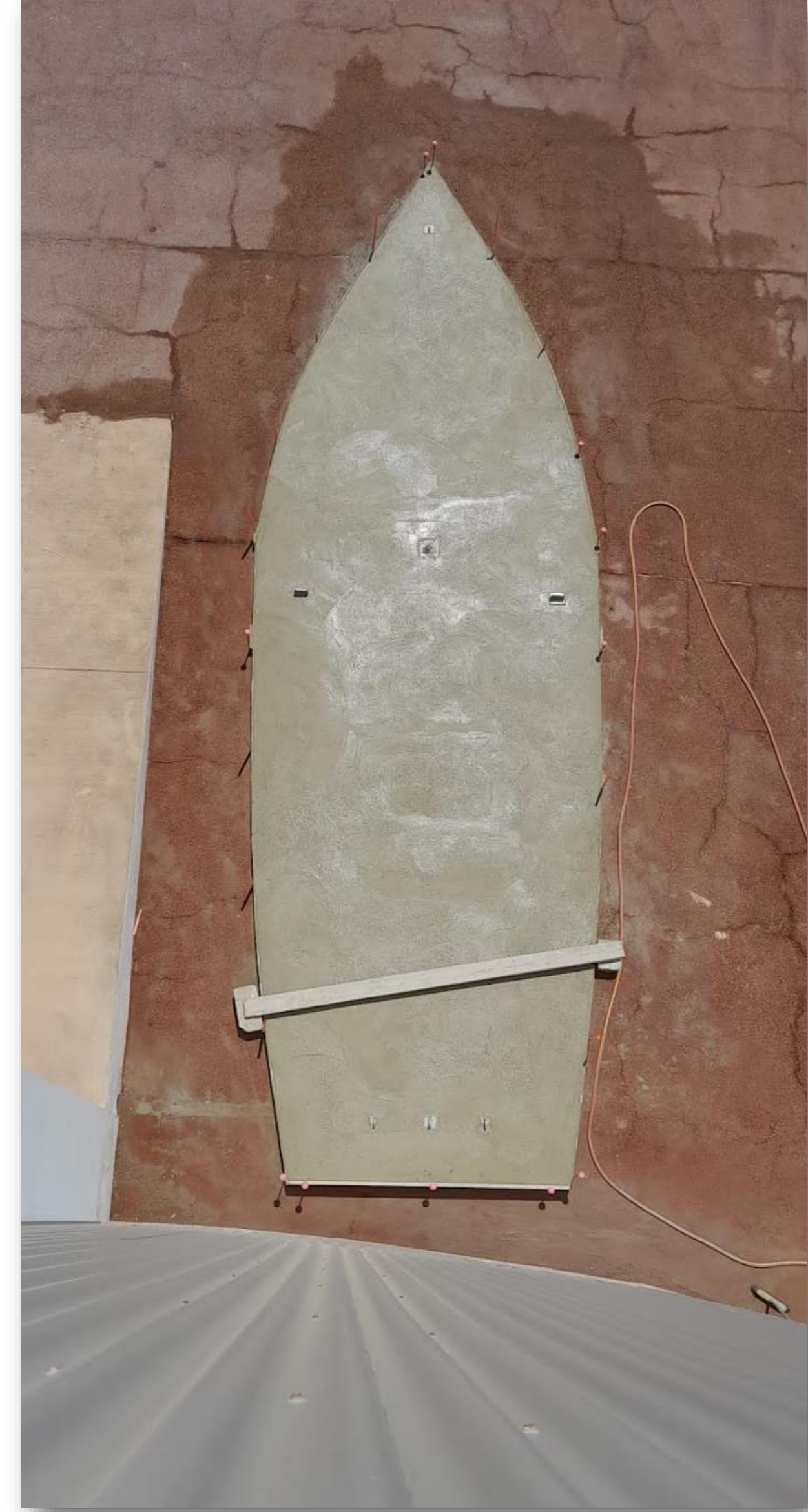
Losa de hormigón armada con refuerzo interior terminada.
