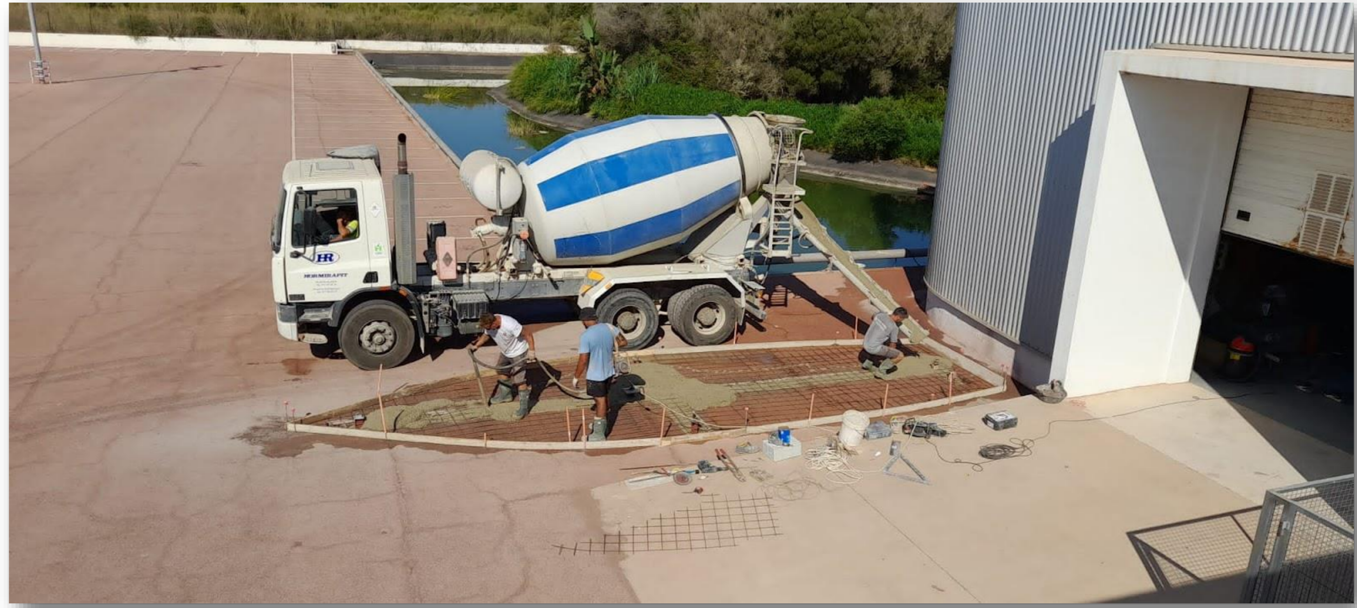
Vertido de hormigón en zanja y losa.
